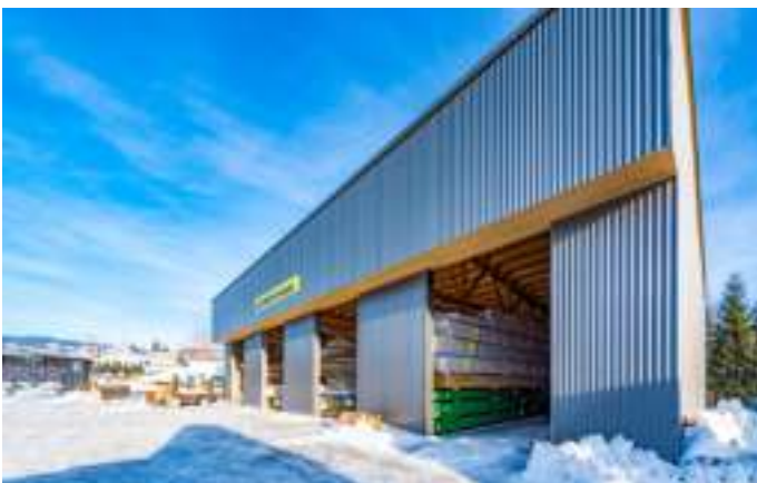
Die neue Lagerhalle
