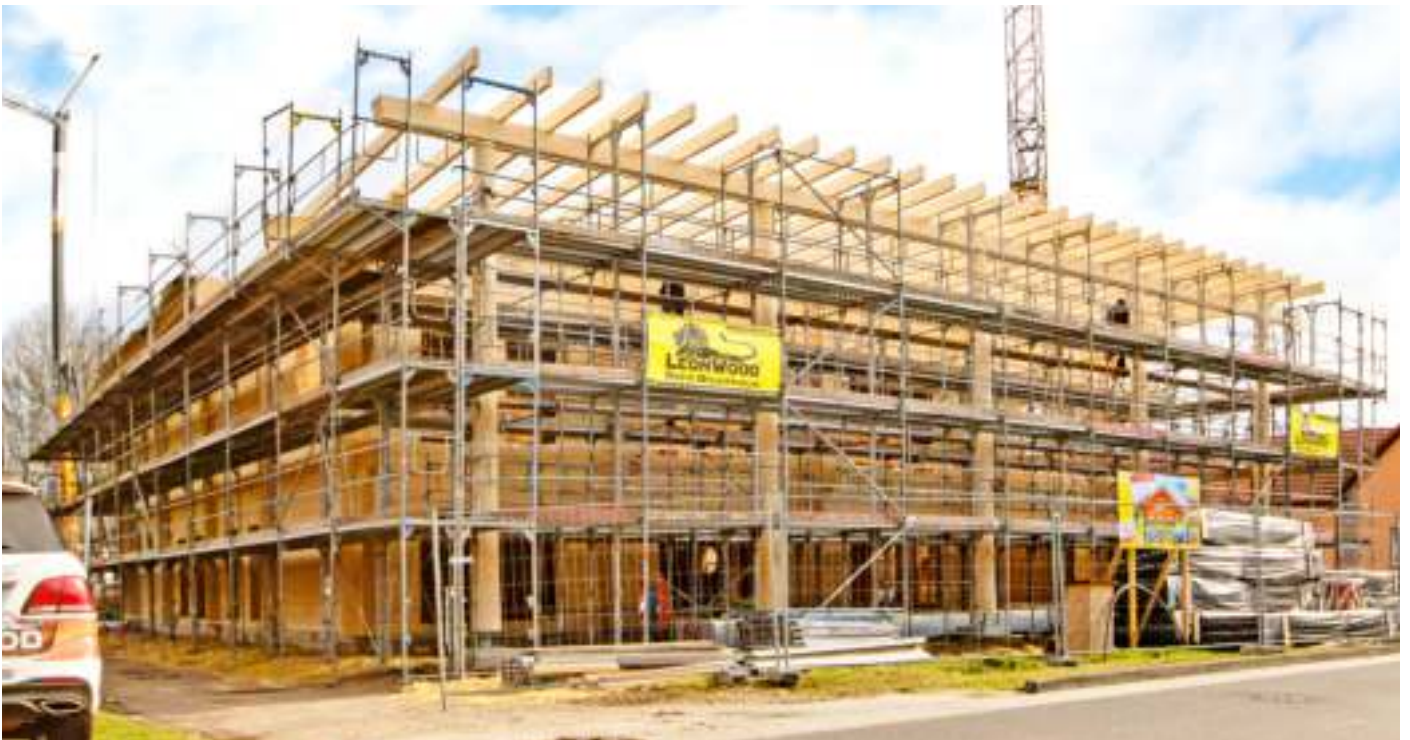
Der Rohbau der LéonWood®-Hauptzentrale in Maust
