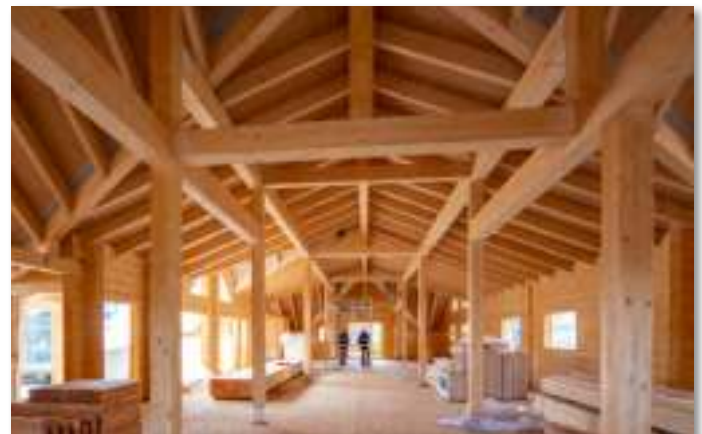
Allein die Dachkonstruktion des Großprojektes findet Investor Thomas Rader schon kolossal: „Wie in einer Kirche!“
