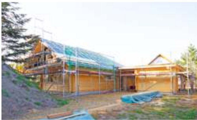
Blockhaus „Canada 120“ mit anliegendem Carport & Geräteraum
