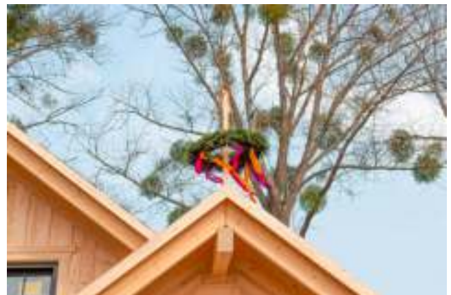
Der Richtkranz steht
