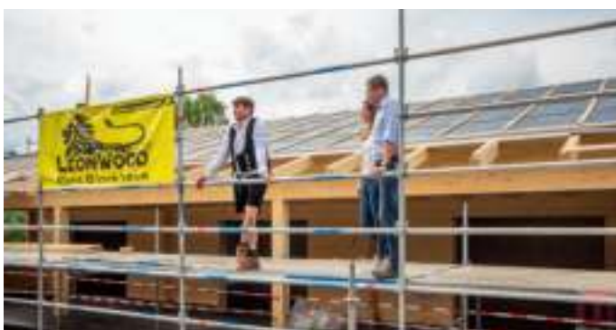
Unser Bauherren-Pärchen lauscht dem Richtspruch des LéonWood®-Richtmeisters Gido Roßbach.
