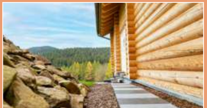
Die Rundstammwand NordicRound* besteht aus 25cm starken Kiefernstämmen.
