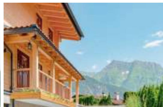
Der Massivholz-Säulengang zur Haustür erinnert an südliche Architektur.
