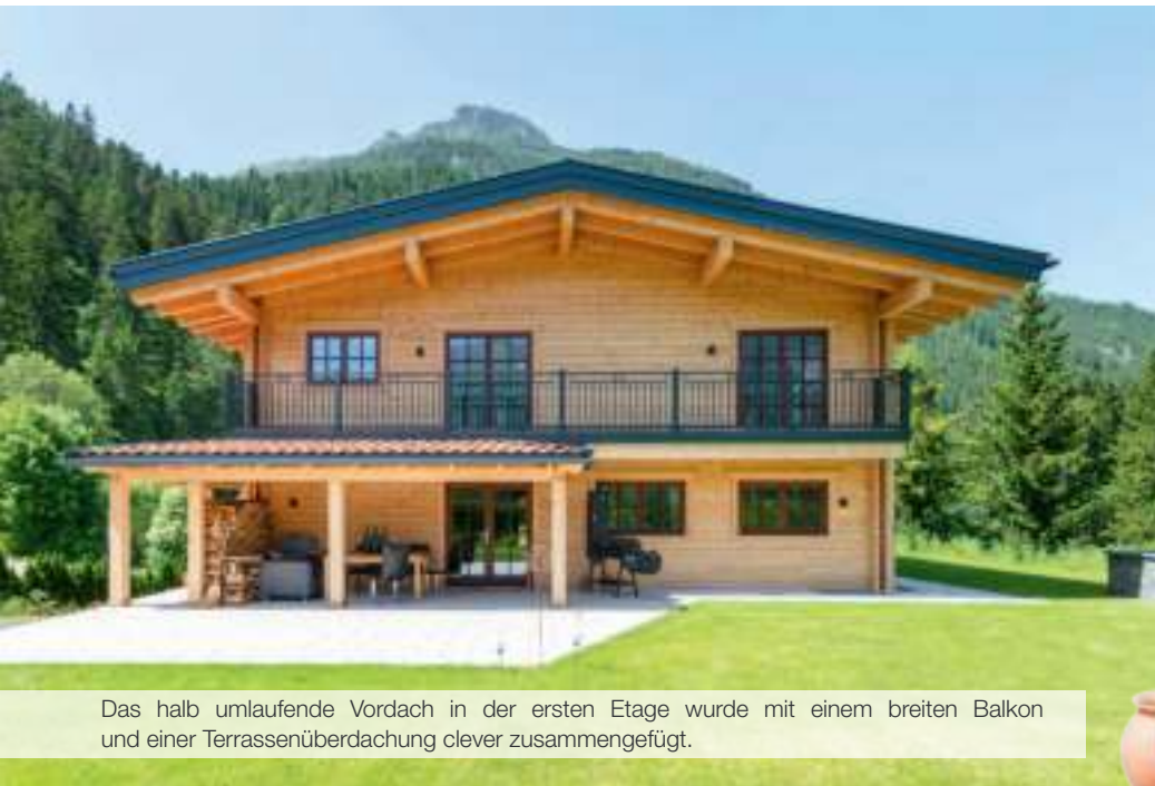
Zum Wetterschutz für die Holzfassade wurden die Dachüberstände vergrößert.
