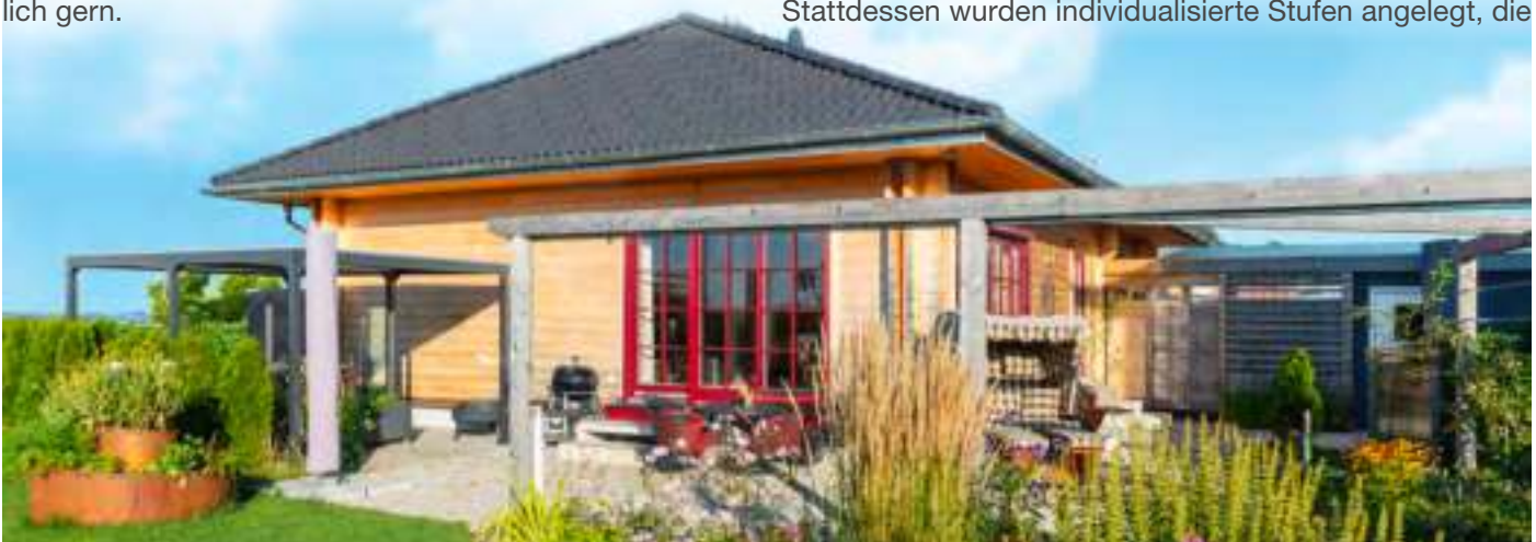
Rückansicht: mit 16m ist dieses „Victoria“ deutlich länger als die Standardvariante. 128m² Wohnfläche steht unserer Bauherrenfamilie damit zur freien Verfügung.
