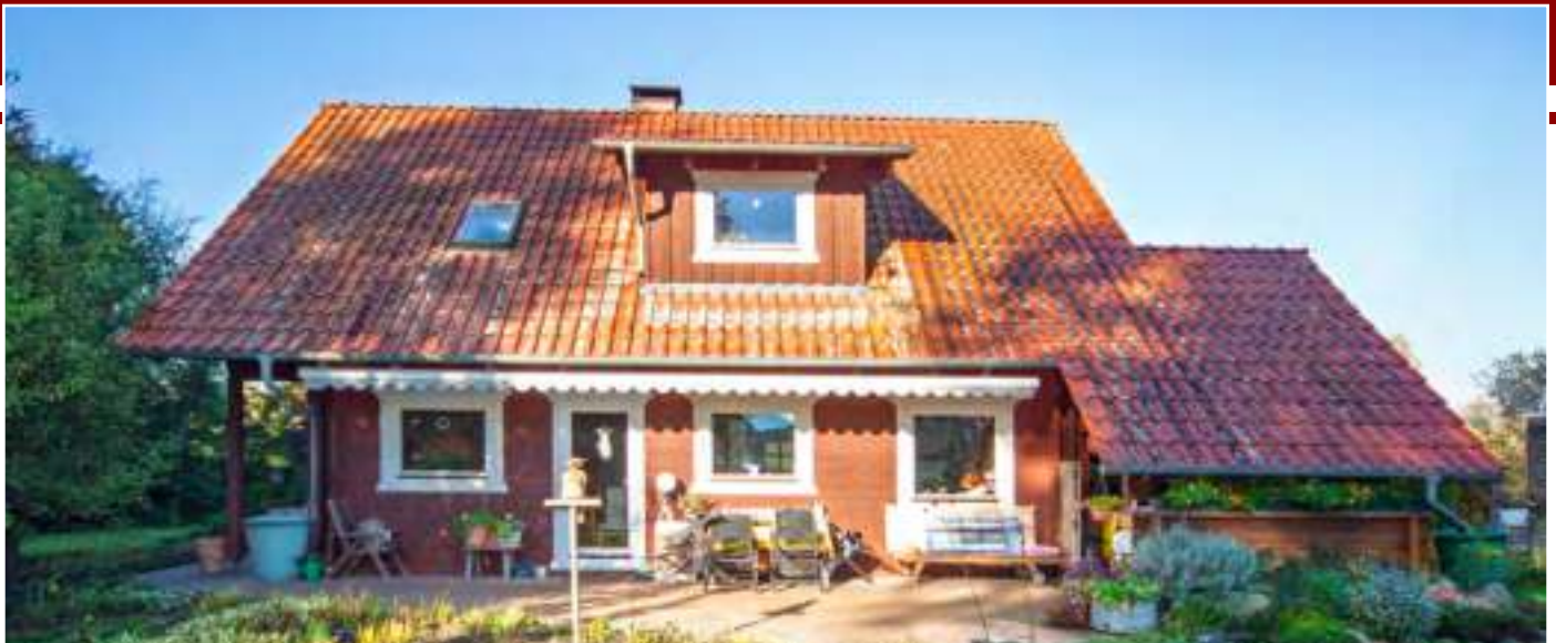
Sonnengeküst ist die rückwärtige Terrassenseite. Eine kleine Schleppdachgaube unterbricht das rote Satteldach. Bündig verläuft es in den Carport von Frau Fricke über.
