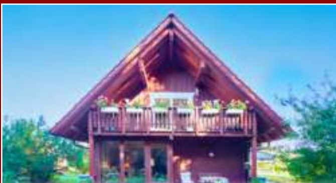
Giebelbalkon-Seite: darunter befindet sich der Wintergarten und eine Terrasse.
