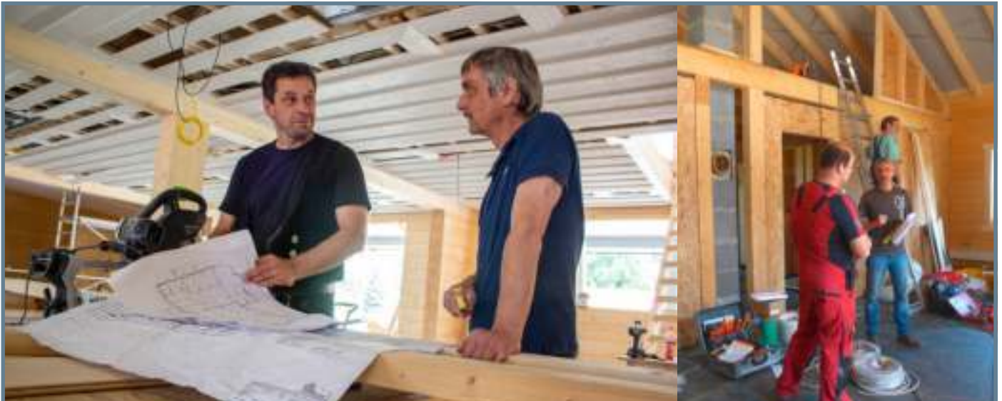
Andreas Knebel in Aktion auf den LéonWood®-Baustellen. Bild links in einer Beratung mit Richtmeister Jens-Peter Kalkbrenner im Geschäfts- und Besucherzentrum. Bild rechts mit einem Elektriker bei einem privaten Bauvorhaben. Knebel hat den Kundenwunsch dabei immer im Blick.
