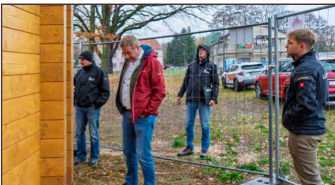
Auch auf der Baustelle aktiv: gemeinsam mit unserer Technikleitung nimmt Josef Egle das von uns gebaute Blockhaus genau unter die Lupe.
