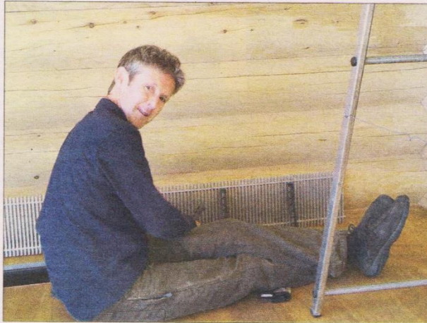
Bis zum Schluss werkelte der Bauherr Jens Weißflog selbst mit und verließ der Relax Lodge den letzten Feinschliff.
