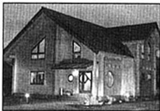
verleimten Léonblock-Bohlen mit einer vierfachen Nut und Feder-Auflage. Es wurden ausschließlich Naturbaustoffe verwendet. Ein kompletter Sonnenschutz (20 Zentimeter Kork als Aufsparrendämmung) und eine Wärmeschutzverglasung garantieren ein ideales Raumklima und sommerlichen Wärmeschutz.
