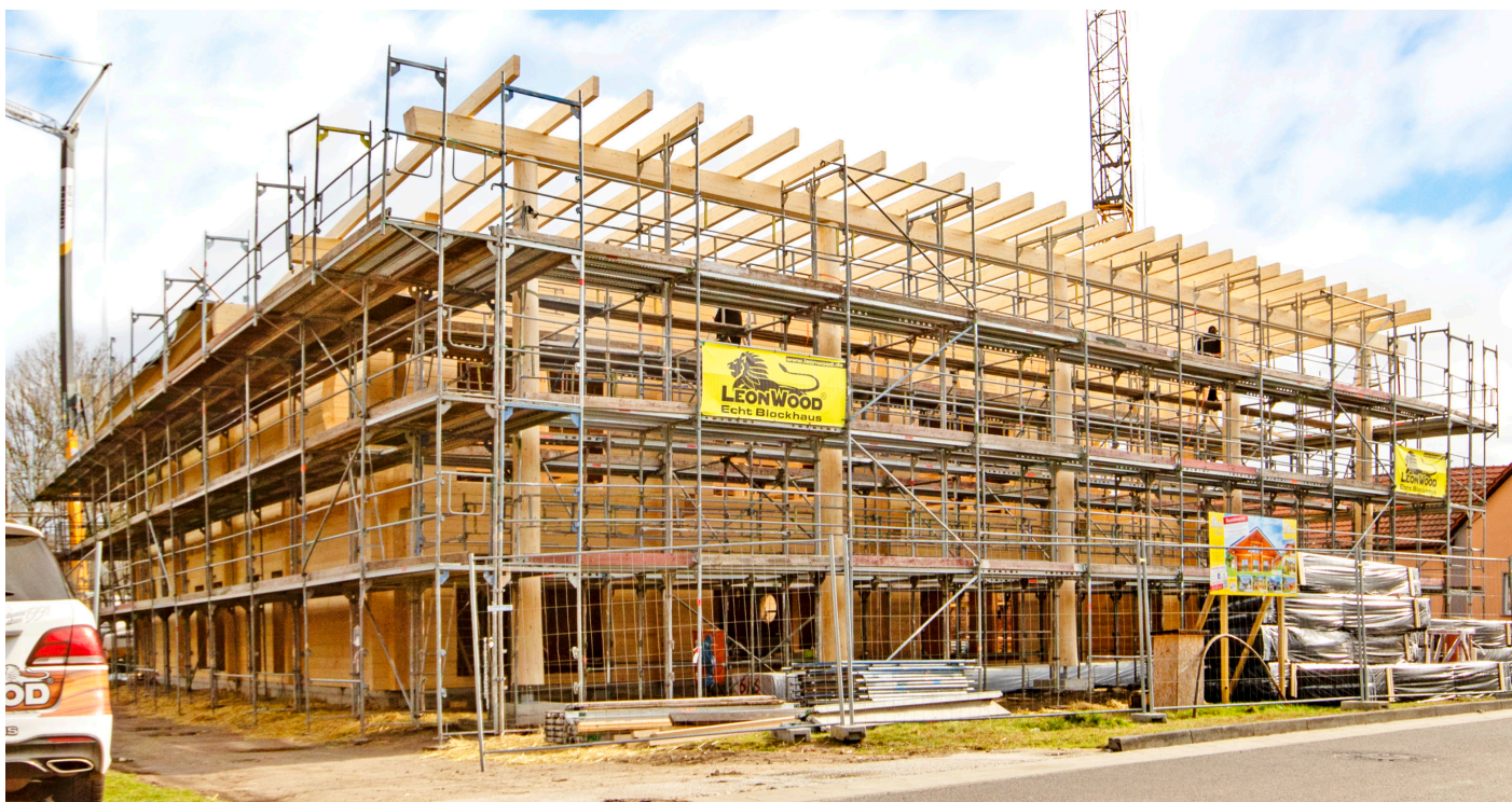
Der Rohbau der LéonWood®-Hauptzentrale in Maust
