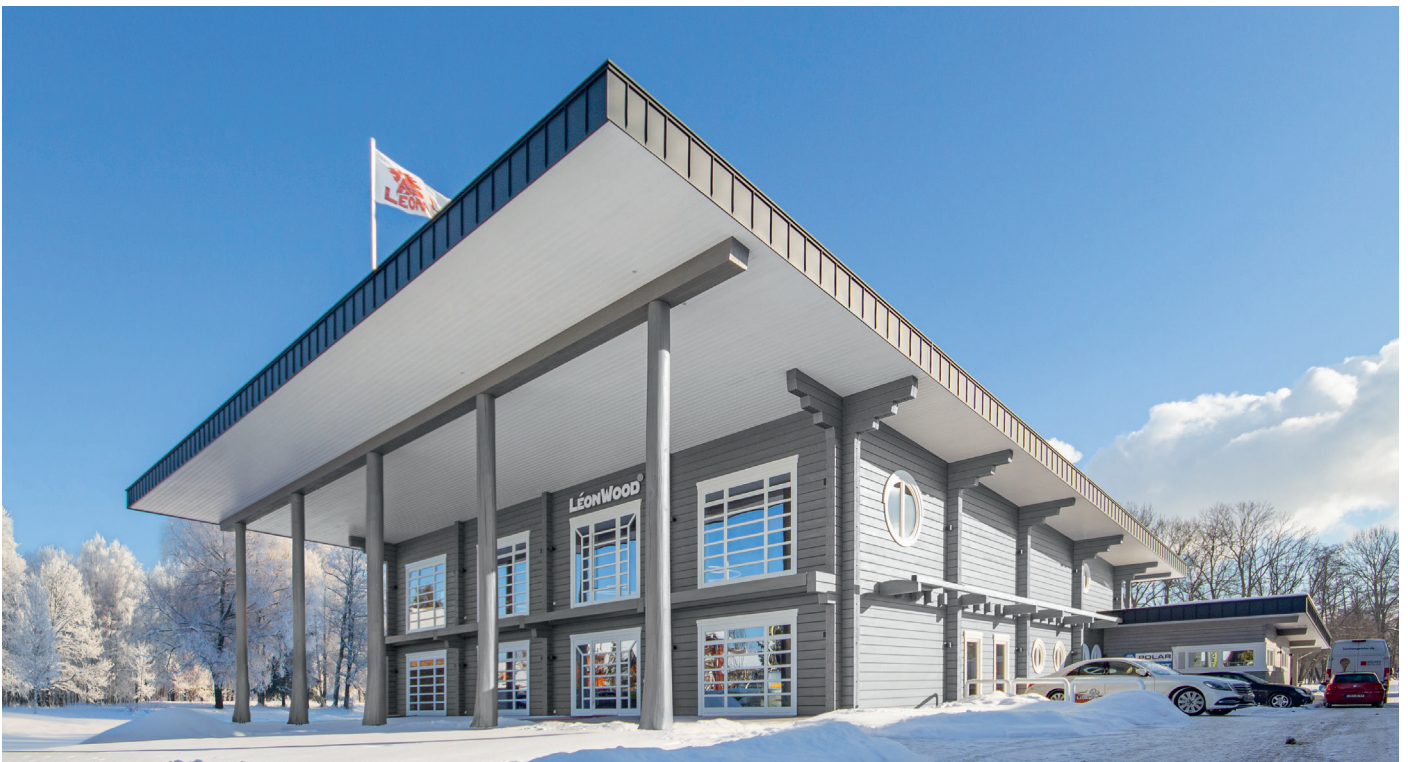
Die neue LéonWood ® -Hauptzentrale in Maust mit den verbauten Naturstamm-Stützen aus der Hohen Tatra
