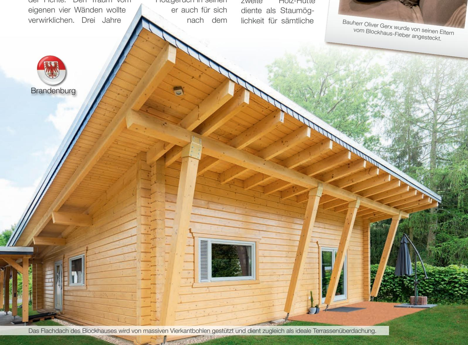
Das Flachdach des Blockhauses wird von massiven Vierkantbohlen gestützt und dient zugleich als ideale Terrassenüberdachung.
