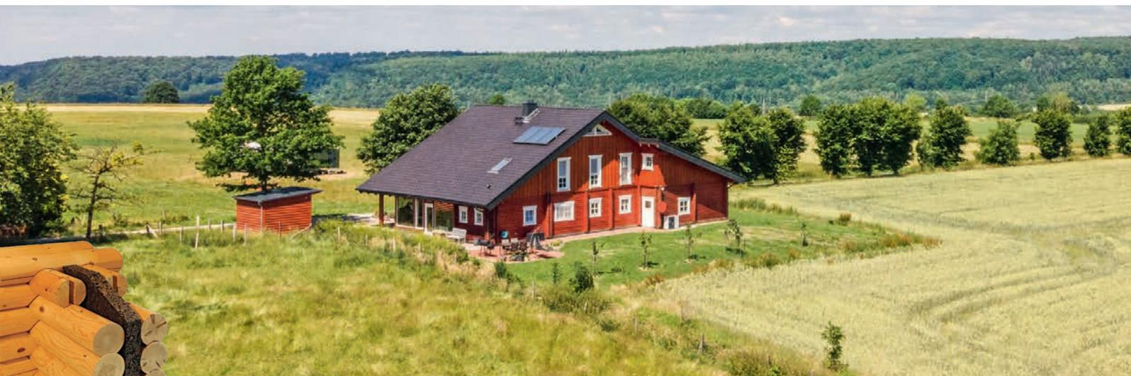
Das rote Blockhaus strahlt kräftig zwischen den grünen Feldern und Bäumen auf dem Winterberg. Die zweischalige Rundstamm-Wand mit innenliegender Korkdämmung ist eine besondere Wandvariante von LéonWood® und weist eine sehr hohe Dämmung auf.
