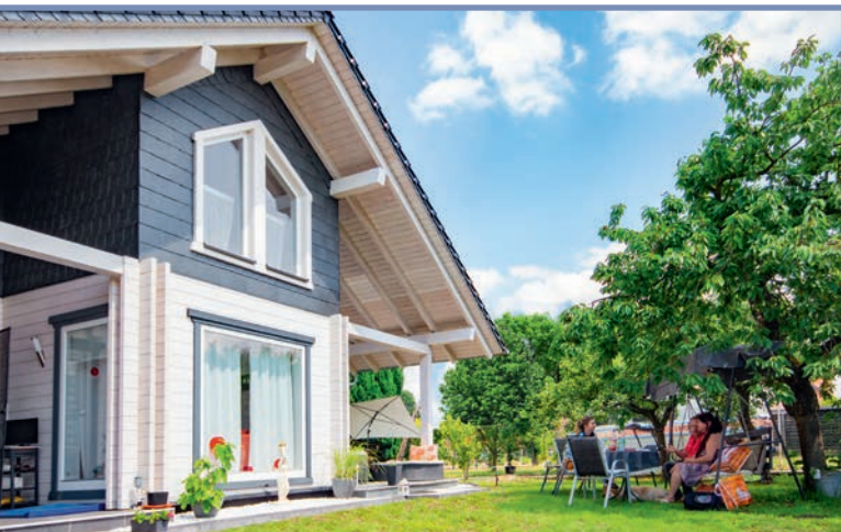
LéonWood® ist fünf Jahre nach dem Blockhausbau zu Besuch. Das Haus ist durch die zwei Sonnen-Terrassen und den Glasgiebel mit dem Garten verbunden.
