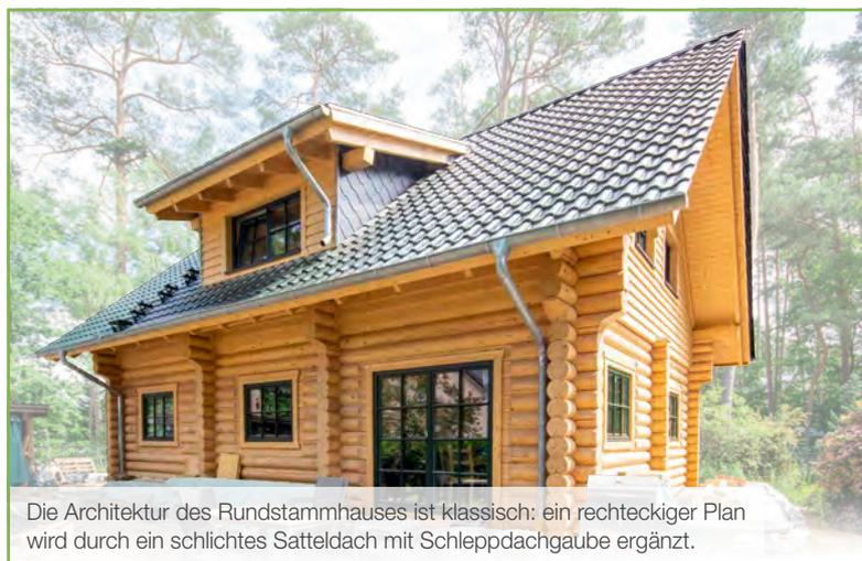
Die Architektur des Rundstammhauses ist klassisch: ein rechteckiger Plan wird durch ein schlichtes Satteldach mit Schleppdachgaube ergänzt.
