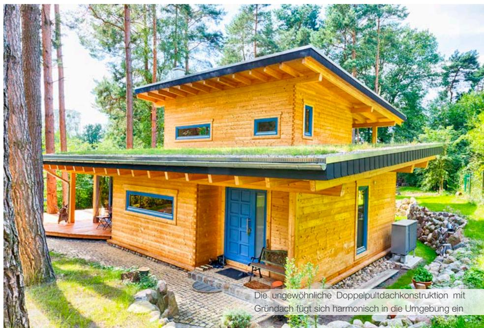
Die ungewöhnliche Doppelpultdachkonstruktion mit Gründach fügt sich harmonisch in die Umgebung ein
