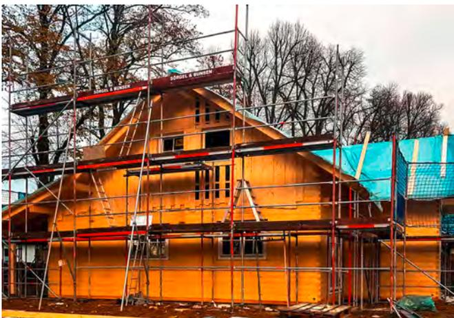
Schön zu sehen ist hier der Kontrast der senkrechten Deckelschalung des Giebles zur waagerechten Blockwand im Erdgeschoss.
