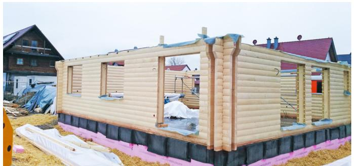
Wohngesunde baubiologische Materialien aus Holz, Hanf und Kork werden als Dämmmaterialien eingesetzt. Das **Niedrigenergiehaus** ist zusätzlich mit dem **Polar-Fußboden** von LéonWood® ausgestattet. Ein Carpot mit Geräteraum schließt sich direkt an das Haus an.
