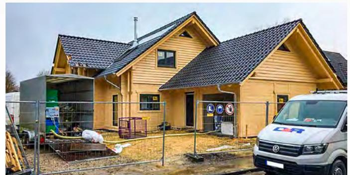
schön mit den gleichliegenden Bohlen der **BIO-Doppelwand**®. Letztere ist, genau wie die Fußböden in Erd- und Obergeschoss, Kork-gedämmt und trägt so effektiv zu Energieeinsparungen bei.
