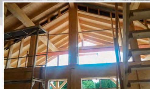
Rahmen gibt die **BIO-Doppelwand®** von LéonWood®, die aus zwei parallel liegenden, massiven Fichten-Bohlen und einer dazwischen liegenden Kork-Dämmschicht besteht. Neben dem Kniestock sind auch die Giebel mit ökologischem Kork gedämmt. Die natürlichen Baustoffe gewährleisten eine besondere Atmungsaktivität des ganzen Hauses und damit verbunden, ein ausgezeichnetes Hausklima.
