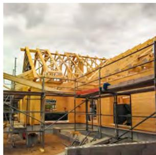
Mit der BIO-Doppelwand® von LéonWood® realisiert, sind auch die ökologischen Bedürfnisse erfüllt: das innovative Wandsystem besteht ausschließlich aus zwei Baustoffen, nämlich **Massivholz** und **Kork**. Beide Baustoffe sorgen durch ihre Materialeigenschaften für eine höchst mögliche Energieeinsparung.
