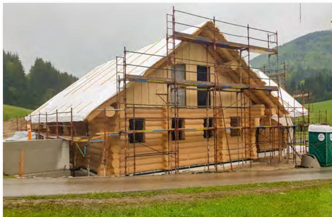
Unsere oberösterreichische LéonWood®-Bauherrin entschied sich für das Komplettpaket: Außenwände in Naturstamm, der vollständige Dachstuhl in Naturstamm, ebenso die sichtbare Holzbalkendecke des Erdgeschosses.
