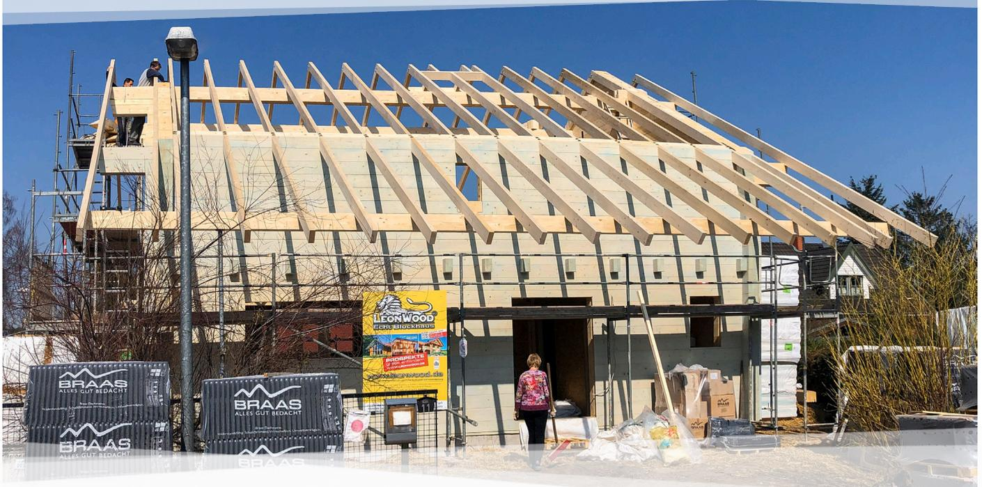
Ein Blockhaus von LéonWood® ist so natürlich wie es aussieht. Außer Holz findet man in den Wänden dieses Blockhauses nämlich nichts. Die 240mm starke Dickbalkenwand LéonBloc\* überzeugt mit minimalistischem Aufbau und kommt ohne Dampfsperre, Dämmschicht oder andere Schichten aus. Im Inneren des Hauses stellt sich ein angenehmes und gesundes Klima ein. Nur in einem Holzhaus lässt sich diese besondere Raumluft erfahren.
