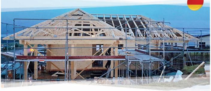
Das Blockhaus Elch, einer unserer rustikalen und ursprünglichen Haustypen, wird derzeit in einer modernen Neuinterpretation bei Idar-Oberstein gebaut. Unsere Bauherren entschieden sich hier für die geradlinige BIO-Doppelwand DuoPlus\* mit innenliegender Korkdämmung. Diese Wandausführung lässt das Blockhaus Elch filigraner und zeitgemäßer wirken. Das charakteristische Walmdach verleiht dem Haus zudem ein elegantes
