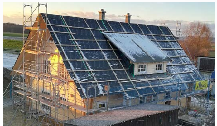
Auffällig ist die 45°-Dachneigung mit den beiden Schleppdachgauben
