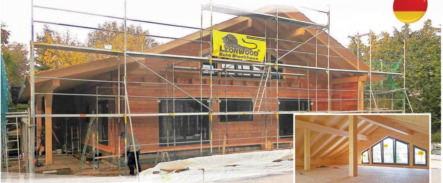
Dieses individuell geplante Blockhaus von LéonWood® besticht durch den **konsequenten Einsatz natürlicher Baustoffe**. Den Anfang macht der zweischalige Wandaufbau BIO-Doppelwand® mit innenliegender Korkdämmung. Besonderheit ist hierbei die Verwendung des besonders witterungsfesten Lärchenholzes für die außenliegenden Blockbohlen. Schon von Weitem zieht die charakteristisch rötliche Färbung den Betrachter in ihren Bann. Neben den Außenwänden, sind auch Dachflächen und Fußboden mit
